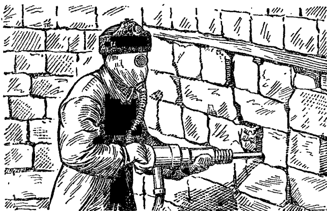
Рис. 41. Пробивание отверстия в стене убежища пневматическим молотком
